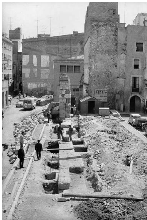
Fig. 107: Vista de los trabajos de pavimentación de la Plaza del Forum en los años 1950. Al tiempo que se modernizaba la plaza se excavaron y restauraron los restos arqueológicos habían sobrevivido con importantes hallazgos de muros romanos in situ y piezas marmóreas.
