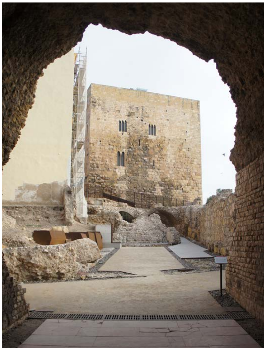
Fig. 128: La primera de las bóvedas del Circo, destinada al tráfico rodado, conduce hasta una escalera y rampa que permitía el acceso a las puertas del Pretori. En este último sector, la bóveda A ha desaparecido como consecuencia de una mina colocada por el ejército napoleónico en su retirada de 1813 cuyos efectos todavía pueden verse claramente.
