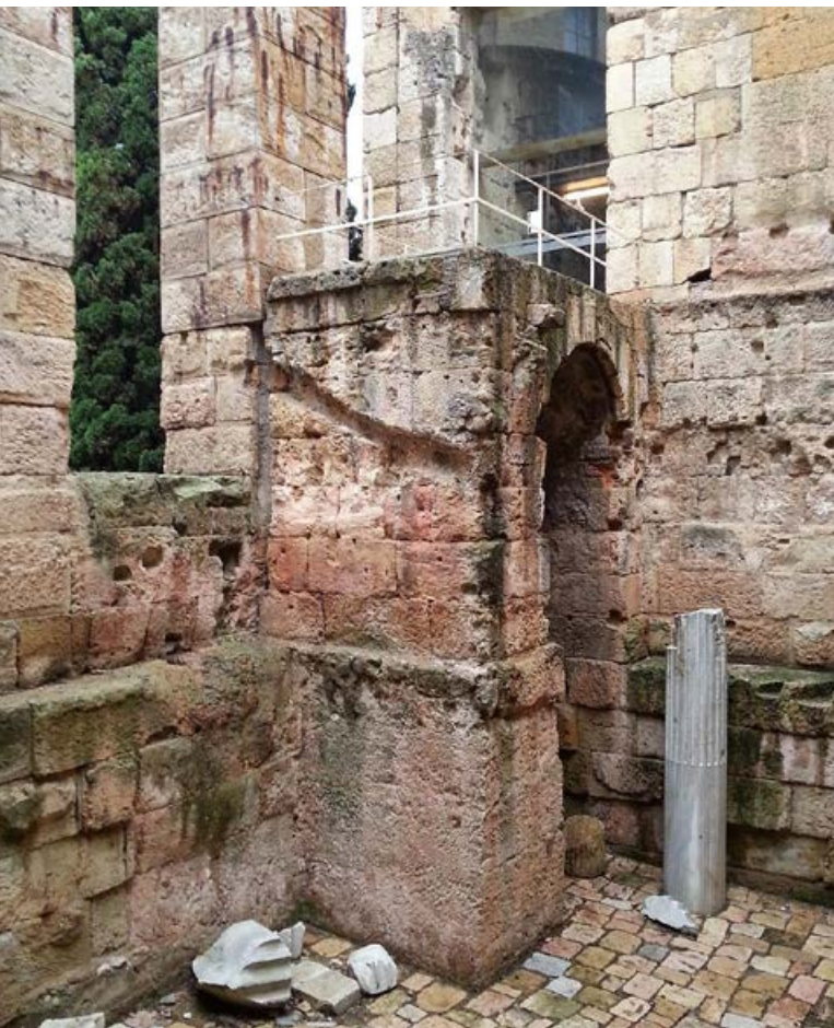
Fig. 94: Interior del Pretorio. En época romana era una gran caja de escaleras para acceder a las galerías que rodeaban la Plaza de Representación. La estructura con el arco es precisamente el descansillo desde el que arrancaba la desaparecida escalera romana.
