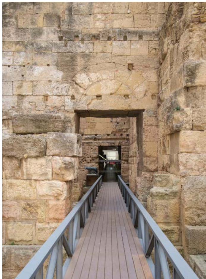
Fig. 95: Vista de las puertas romanas que permitían acceder a la caja de escaleras y desde ella a las galerías inferiores de la plaza. La pasarela moderna recupera el nivel romano de circulación en la base de la antigua escalera.
