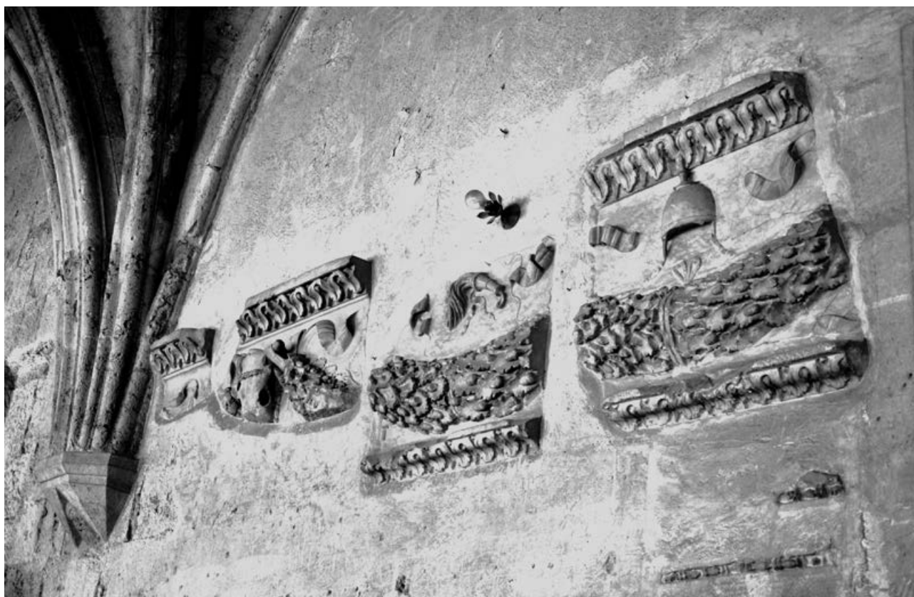
Fig. 40: Al igual que el friso de la figura 39 y otros fragmentos conservados en el MNAT, los bloques arquitectónicos del claustro de la Catedral pertenecieron a un gran edificio sacro construido en época flavia en la Acrópolis de Tarragona. Se encontraron en el siglo XIX en las obras realizadas en la Catedral y fueron colocados en una de las paredes del claustro. El motivo decorativo de los bucráneos (cráneos de buey) unidos por guirnaldas y la presencia de los símbolos sacerdotales sigue el modelo de la decoración del templo dedicado al Divo Vespasiano construido en el foro de Roma.
