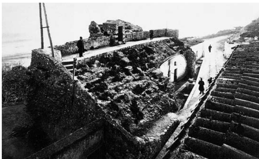
Fig. 138b: Restos del graderío del Anfiteatro a fines del siglo XIX con instalaciones y garita de vigilancia del vecino presidio (foto Archivo Mas).
