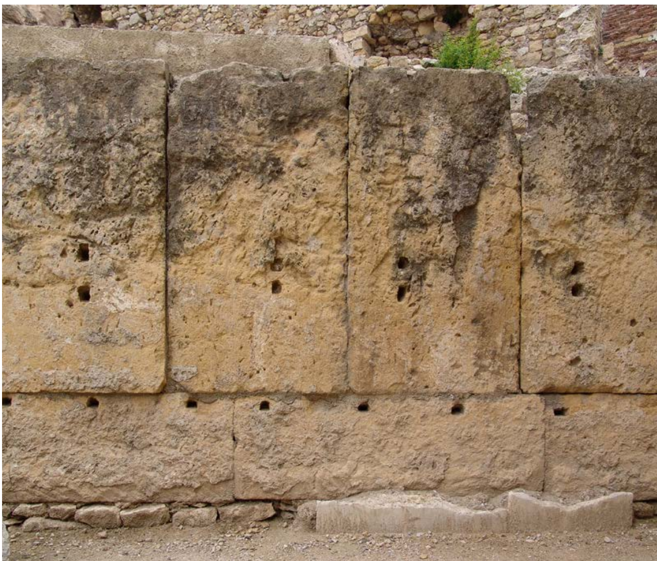
Fig. 199: En un momento tardío, ya en pleno siglo III d.C. el podio fue de nuevo restaurado con un nuevo placado para el cual se reutilizaron pedestales estatuarios aserrados. Vista de detalle de los ortostatos del podio y las encajes para las grapas que sustentaban las placas cuyos restos todavía son visibles en la base de la obra.
