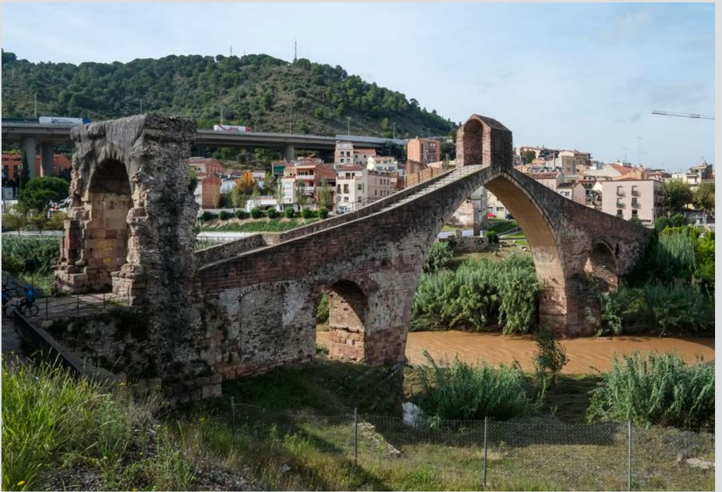
Fig. 11: Vista del puente de Martorell tomada desde el lado norte del río Llobregat. El acceso al puente por este lado se realiza todavía pasando bajo uno de los dos arcos que flanqueaban el primer puente romano del que se conservan tan solo los paramentos bajos en sillería de sus dos extremos. El resto de la obra es de época medieval, moderna y contemporánea ya que el puente ha tenido que ser reconstruido en diversas ocasiones.
