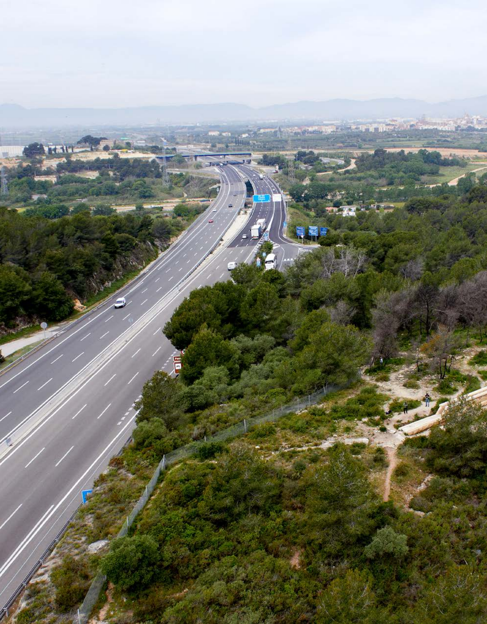
Fig. 33: Vista aérea del acueducto de Les Ferreres junto a la autopista AP 7 (P. Segura y S. Morón / Aeroproducciones).
