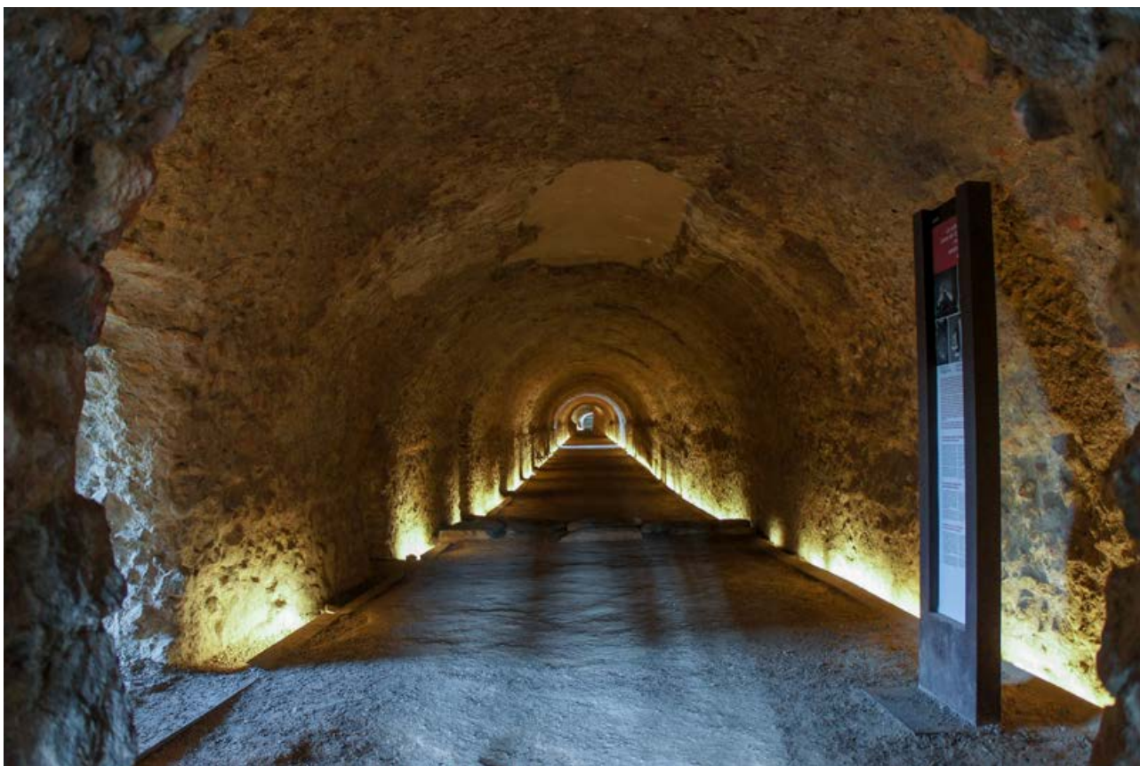
Fig. 132: Vista de la bóveda larga del Circo bajo la calle de l'Enrajolat. Esta bóveda, colocada en sentido longitudinal respecto a la pista del Circo y comunicada con pequeñas bóvedas transversales para sostén del graderío, se adosaba al gran muro de aterramiento de la plaza provincial, aquí situado a la derecha de la imagen.
