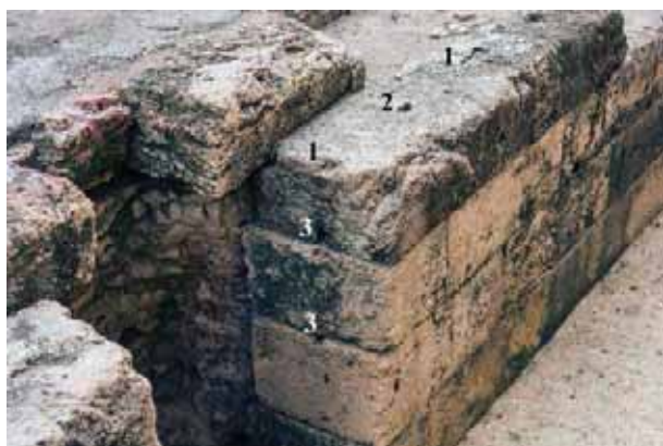
Figura 12. Detalle del muro del podio. Elementos de sujeción o manipulación de los bloques.
