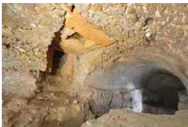
Figura 20. Detalle del sector 3, con la canalización de desagüe.
