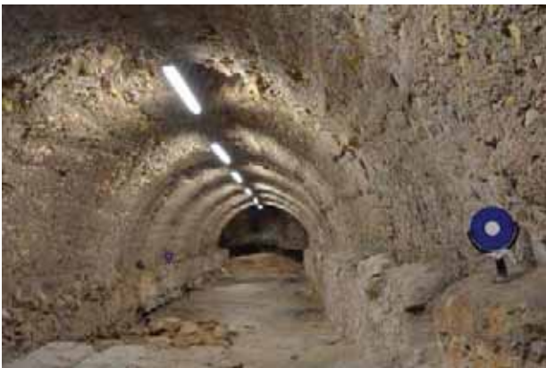
Figura 18. Vista de la bóveda del sector 6.
