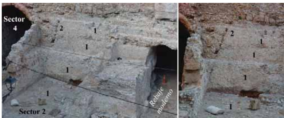
Figura 21. Vista de la plataforma de sustentación/conformación del graderío. 1) tongadas de fraguado; 2) límite W de la plataforma.
