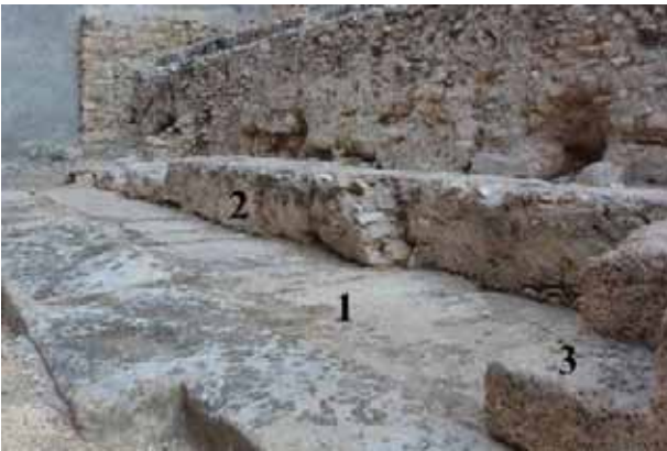
Figura 17. Detalle del núcleo de caementicium (2) y de las huellas de los sillares de asiento en el lecho de preparación (1).
