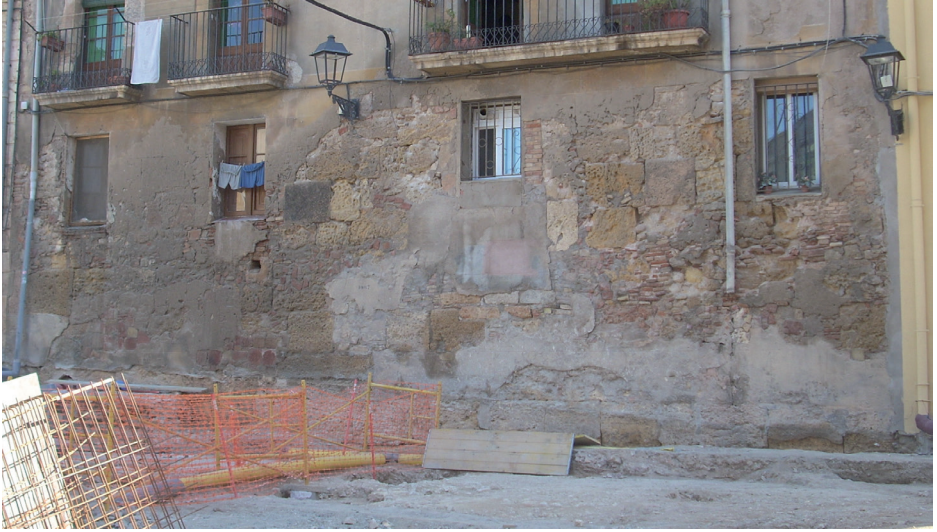
Figura 2. Part baixa de la façana, abans de la restauració i durant les obres del carrer que van deixar al descobert dues filades més de carreus.
