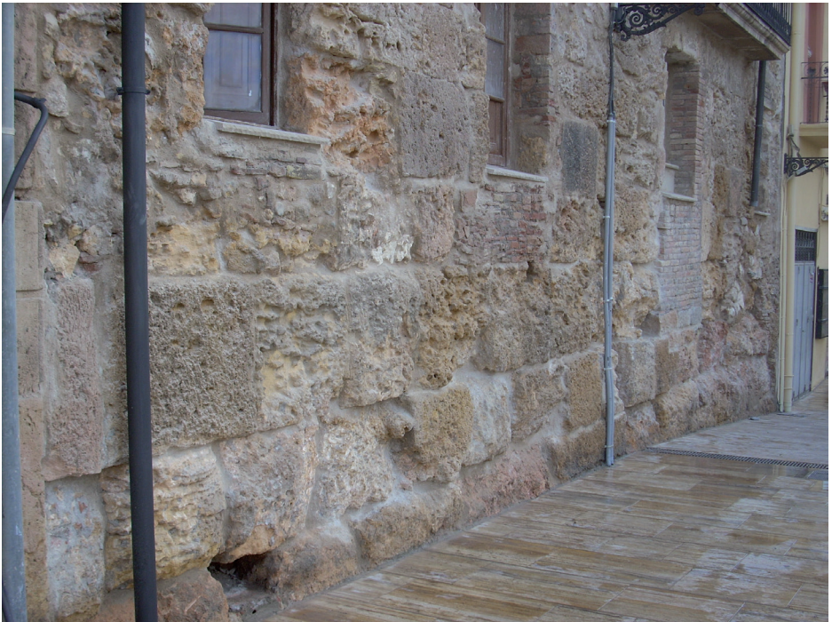
Figura 3. Murs de carreus després de la neteja i restauració.
