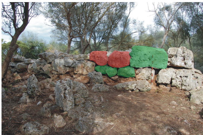
Figura 7. Restauració del flanc sud-oest de T1. Reposició de pedres originals (en verd) i aportades (en vermell).
