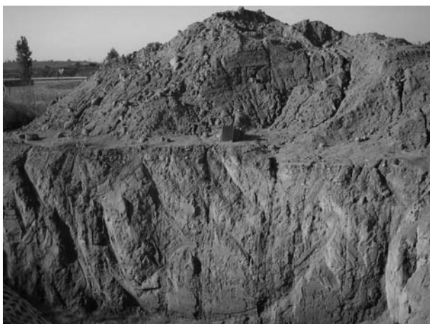
Figura 5. Excavació de 3 m 2 . Estrat indefinit d'argila.
