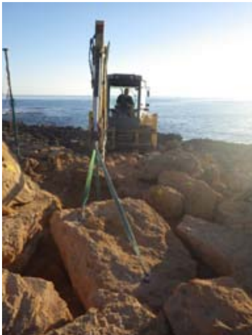
FOTO 21. Feines realitzades: procés d'enretirada de la llosa de coberta (UE 6) de T133.
