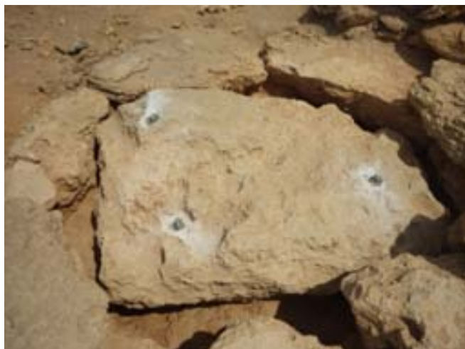
FOTO 25. Fixació amb resina epoxídica d'anelles d'acer per poder embragar la llosa.
