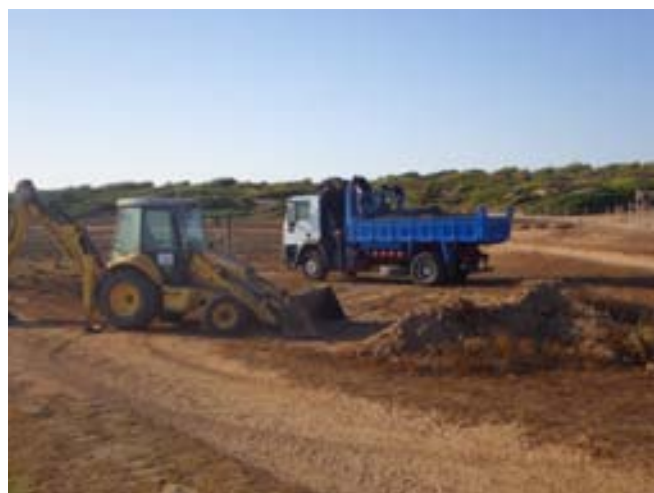
FOTO 11. Feines realitzades: extracció de la terrera formada durant la intervenció de 2015.
