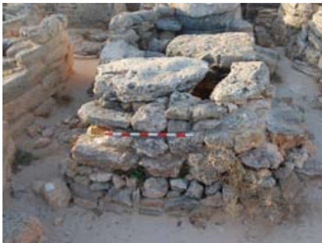
FOTO 3. Estat previ. Desperfectes de tombes prèviament consolidades.
