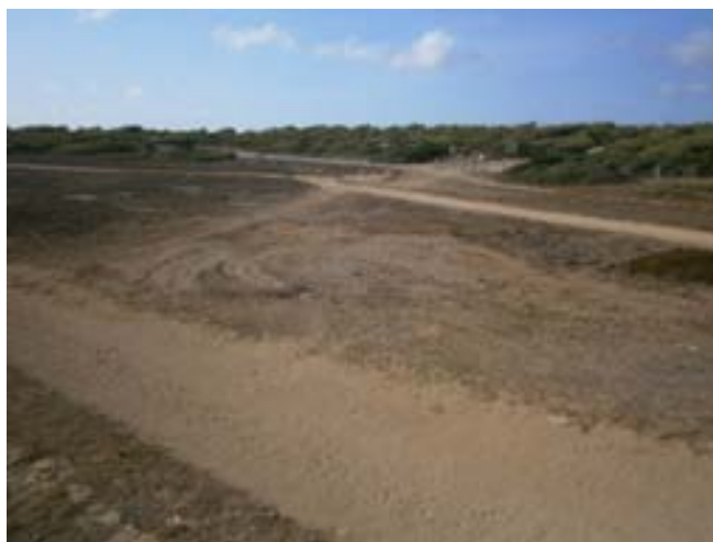
FOTO 12. Feines realitzades: Extracció de la terrera formada durant la intervenció de 2015.
