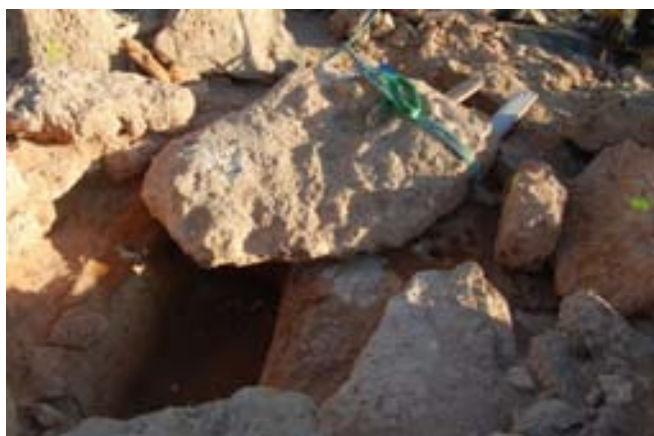
FOTO 27. Enretirat de la coberta amb l'ajut d'una retroexcavadora.
