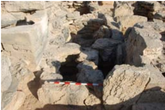
FOTO 19. Fotografia després de la intervenció on està senyalat la zona on s'ha reforçat el mur en les seves parts baixes. Les filades superiors no han sofert cap tipus de modificació.
