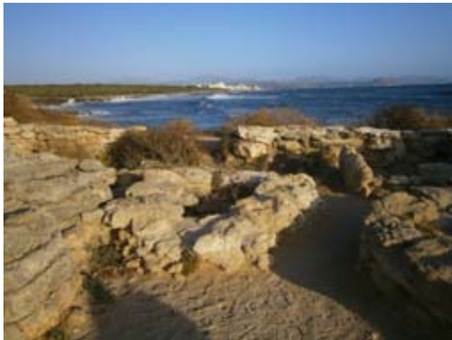
FOTO 1. Estat previ. S'observa el creixement de vegetació damunt les estructures i els seus voltants.
