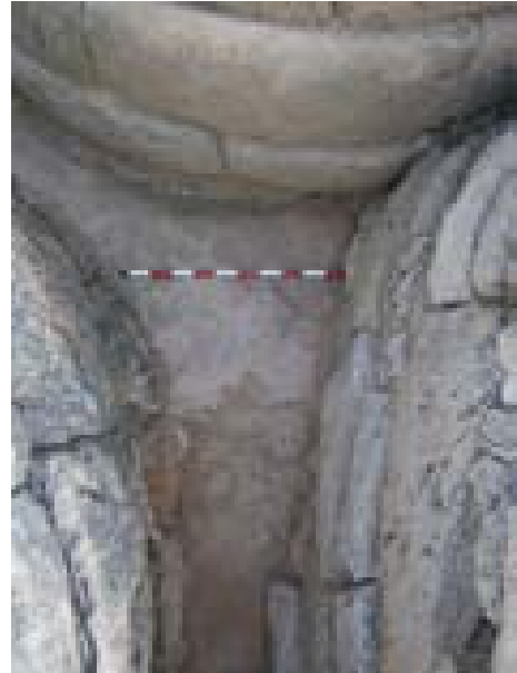
FOTO 74. Sector T1-7. Roca de base (UE 1000). Estat final.
