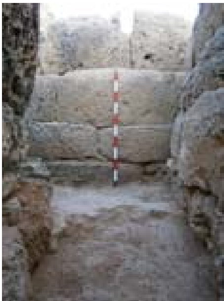
FOTO 75. Sector T1-7. Al fons s'observa T1, que presenta sòcol i s'assenta a la roca de base (UE 1000), per la dreta se li adossa T4. Estat final.
