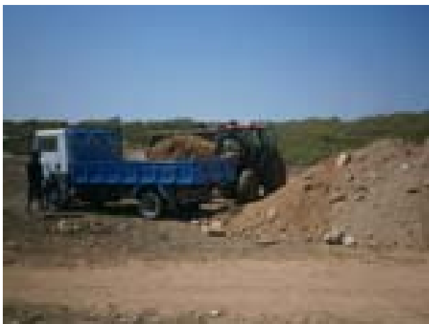
FOTO 15. Feines realitzades: enretirada de les terres mogudes.
