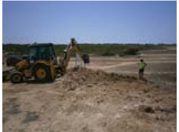
FOTO 14. Feines realitzades: control de la retroexcavadora i anivellament de la banda sud-oest del jaciment.
