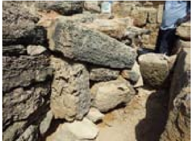
FOTO 20. Fotografia cantonada T8 amb T13, una vegada esbaldregat.
