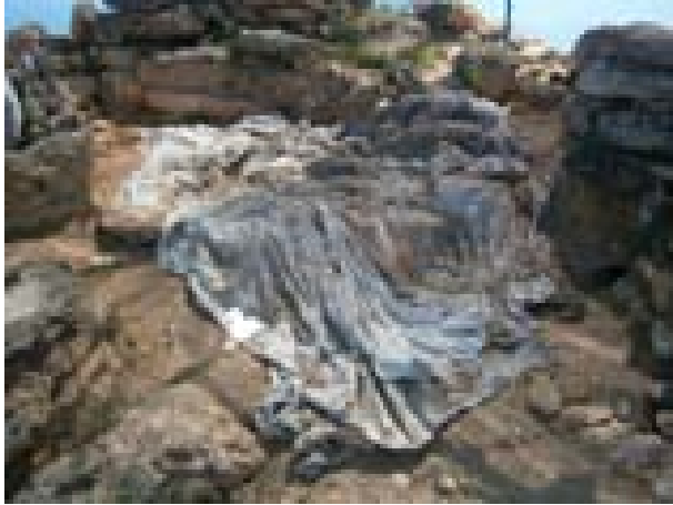
FOTO 9. Feines realitzades: enretirada del geotèxtil. Sector T51-106.
