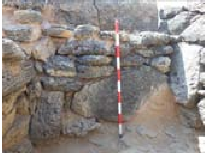
FOTO 12. Detall del fonament realitzat al mur sud.
