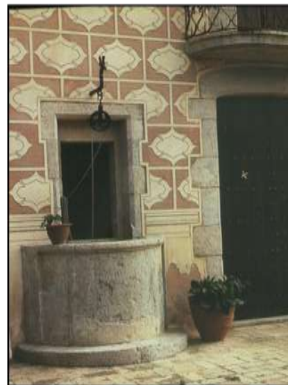
Pou adossat a la façana principal de la masia de Callús (Bages).
