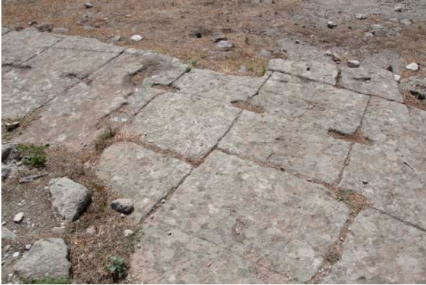
Figura 10. Pergamo. Asklepieion: Tempio di Zeus Asklepios. Tracciati circolari per la esecuzione, allineamento e montaggio della muratura del tempio.
