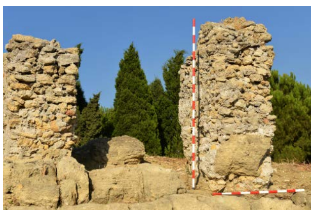
Figura 7. Contrafuertes de la cavea del teatro de Carteia . Opus caementicium .
