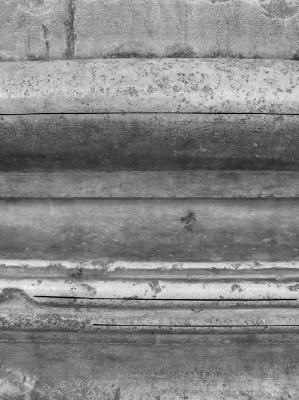
Figura 4. Roma. Pantheon. Curva generatrice incisa tangente al toro della base del pilastro.
