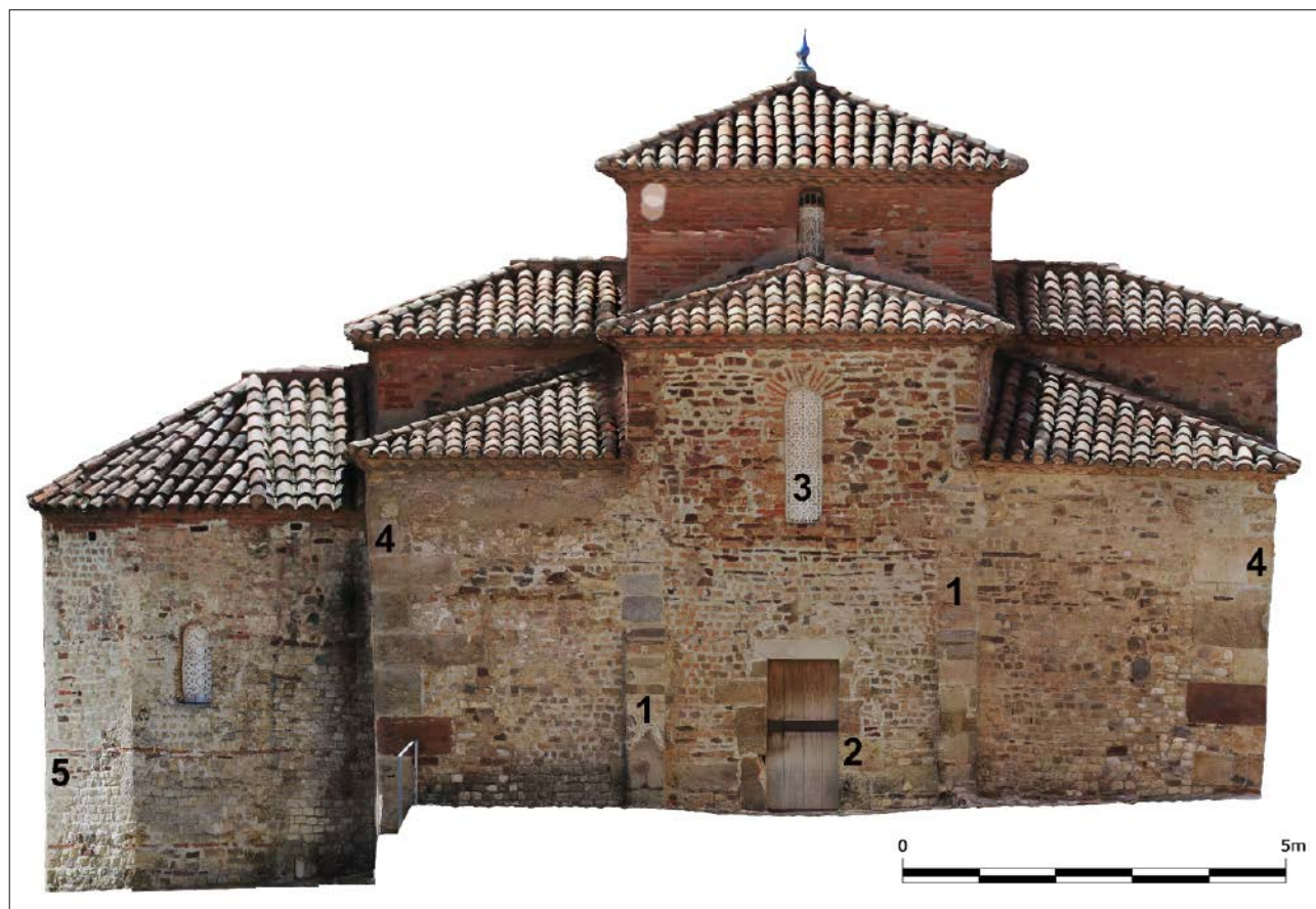
Figura 5. Alzado fotogramétrico del paramento norte del edificio, sin el zócalo del corredor (Archivo ICAC-UDG).
