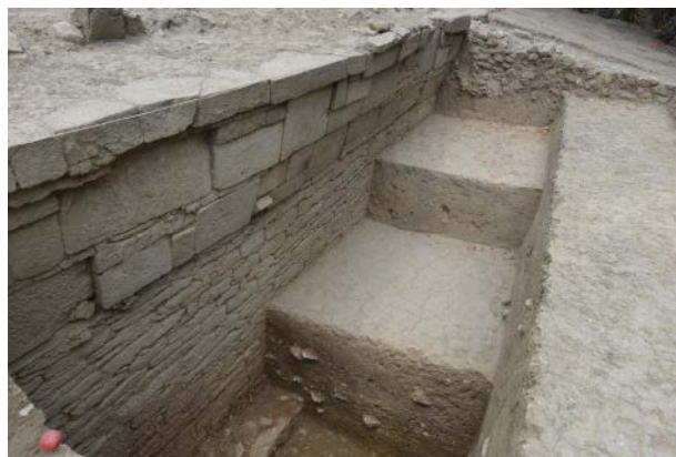
Figura 3. Carteia . Aparejo de la muralla púnica en el área de excavación 113 en 2013. © Proyecto Carteia de la UAM / Junta de Andalucía (2013).
