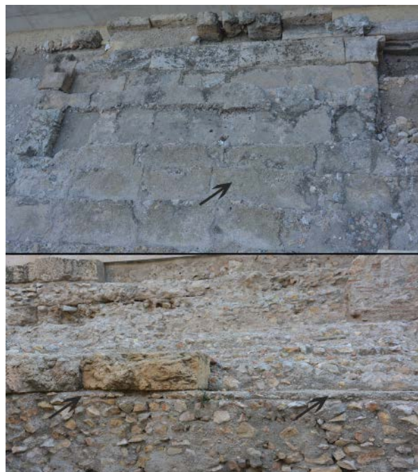
Figura 24. Vistas de la lechada de asiento de los sillares de la gradería.
