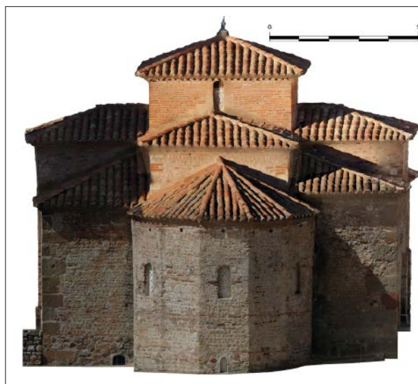
Figura 13. Alzado fotogramétrico de la fachada este (Archivo ICAC-UDG).
