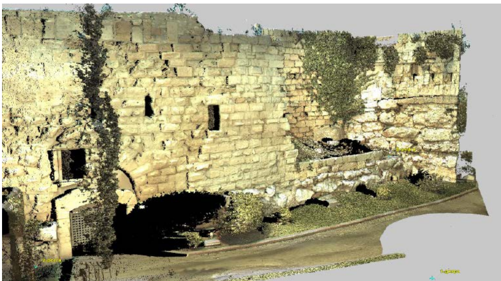
Figura 6. Nube de puntos con asignación del color real de un escaneo láser. Muralla de Tarragona, área del portal dels Socors.
