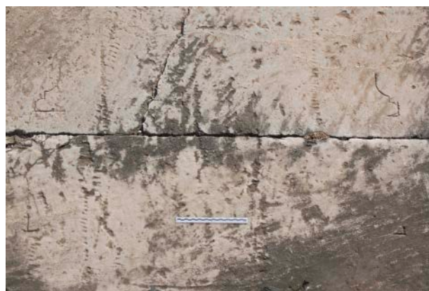
Figura 9. Pergamo. Tempio di Dioniso. Incisioni in scala 1:1 della base della colonna.
