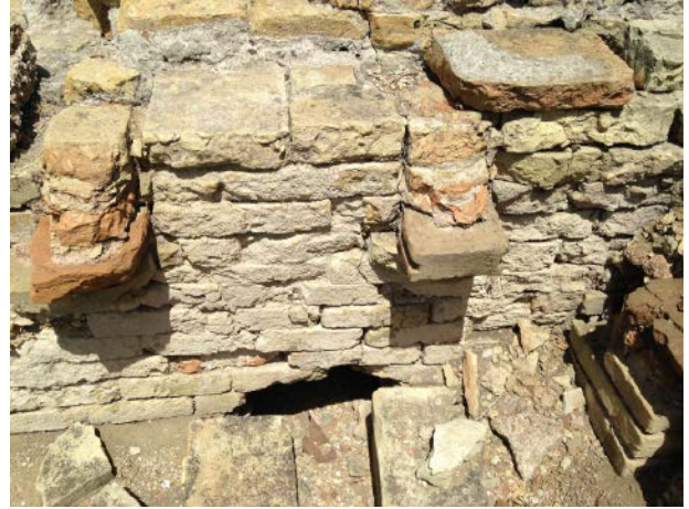
Figura 14. Termas de Carteia . Detalle del muro de ladrillo y de la suspensura del tepidarium . © Proyecto I+D+i de HAR2012-36963-C05-01 (2014).
