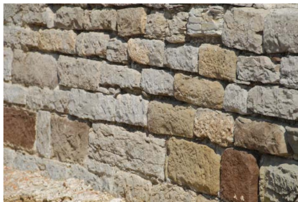
Figura 8. Detalle del paramento norte de la fachada de la domus republicana de Carteia (San Roque, Cádiz). © Proyecto Carteia de la UAM / Junta de Andalucía (2007).
