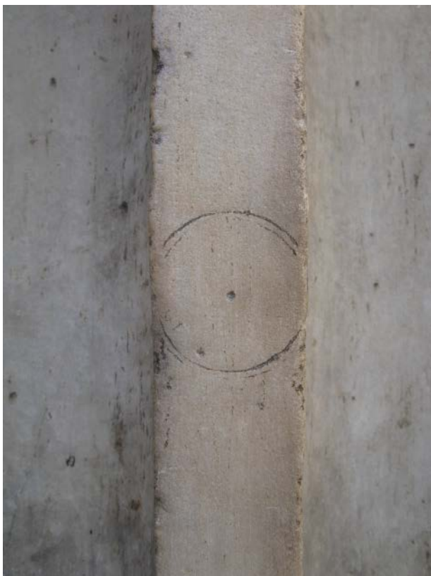
Figura 6. Roma. Pantheon. Incisioni per le costruzioni geometriche delle striae.
