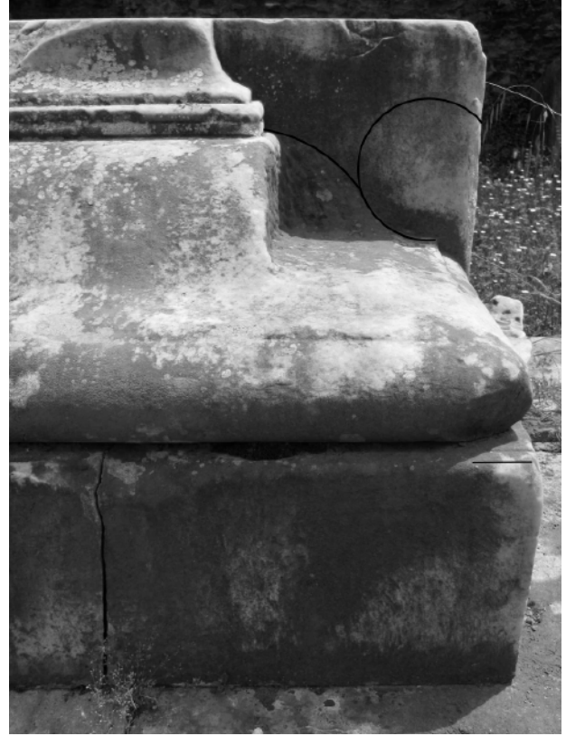
Figura 5. Roma. Tempio dei Castori. Incisione tangente alla curvatura della gola per l'elaborazione della gola stessa.
