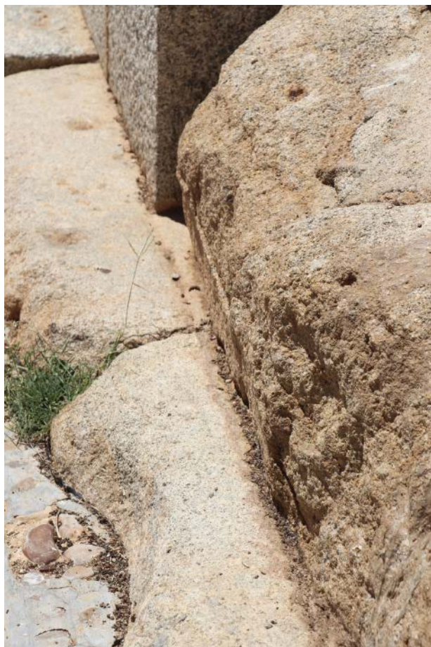
Figura 13. Lusitania. Distilo di Zalamea. Tracciati per l'allineamento ed il posizionamento degli elementi sul crepidoma.
