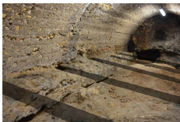
Figura 23. Detalle del extremo occidental del sector 6. Estribo de carga con encajes de encimbrado.
