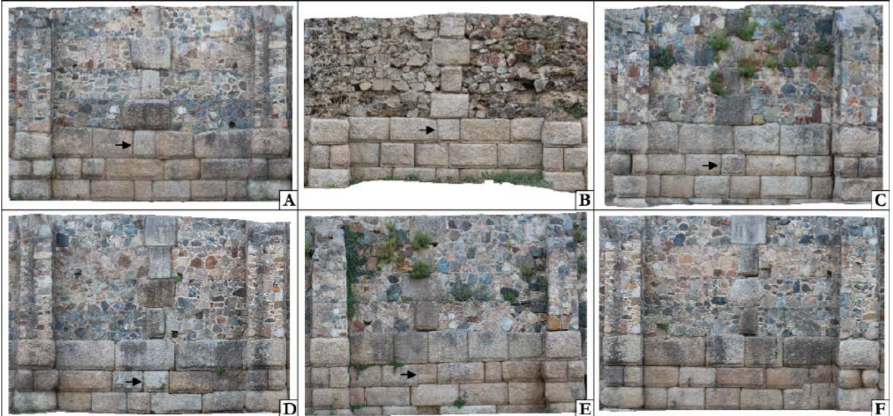
Figura 17. Tipi di apparecchiature dello zoccolo in opera quadrata; la freccia indica la posizione dei blocchi di Testa.
