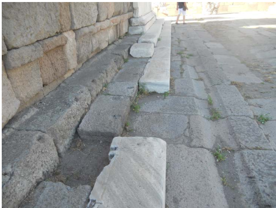
Figura 8. Pergamo. Trajaneum: Tempio di Adriano. Incisioni realizzati sul crepidoma per la suddivisione, allineamento e montaggio.
