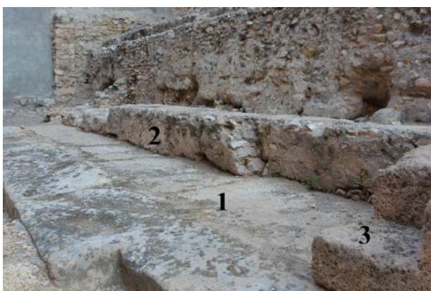
Figura 17. Detalle del núcleo de caementicium (2) y de las huellas de los sillares de asiento en el lecho de preparación (1).
