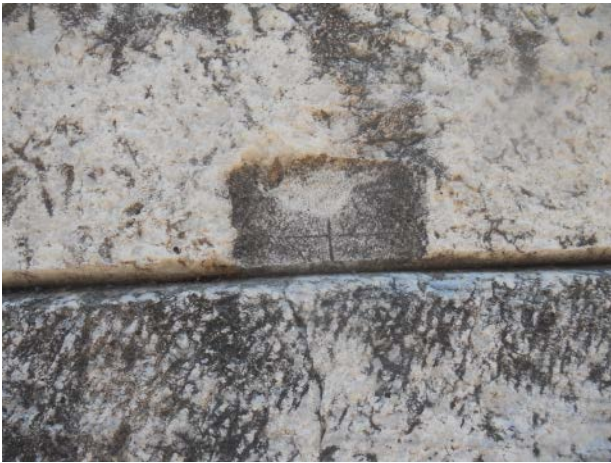
Figura 11. Sardi. Tempio di Artemide. Tracciati per la segnalazione del livello di finitura del fusto.
