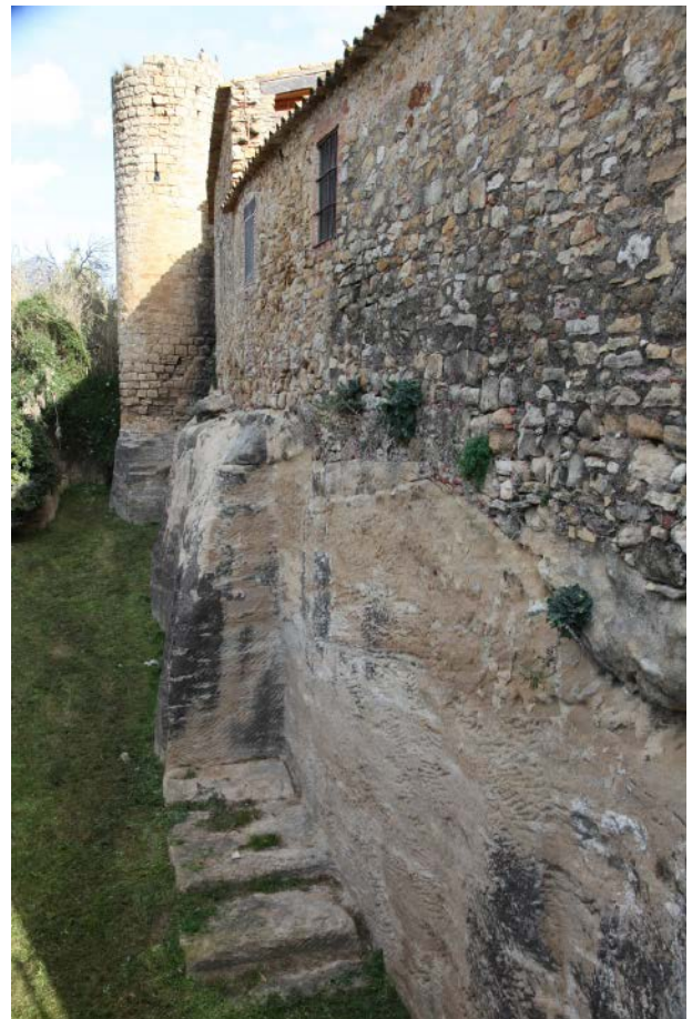
Figura 6. Foso oeste de la villa medieval de Peratallada (siglos x-xii d. C.). En el fondo se observan huellas de extracción de bloques paralelepípedicos y trazas con escoda en diagonal. El topónimo actual deriva de pedra tallada (piedra cortada).
