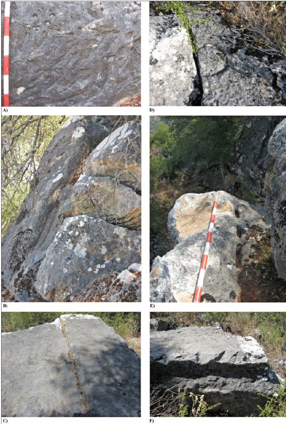
Figura 4. Huellas de diferentes procesos extractivos e herramientas sobre los frentes. A) Huellas características de herramienta de percusión lanzada. B) En segundo plano, delimitación perimetral de un bloque de gran tamaño en posición vertical. C). Línea recta posiblemente trabajada con cincel. D) Línea similar a C), sobre una superficie plana picoteada junto al trazado de un círculo con puntero. E) Línea de oquedades para cuñas, en la zona alta del frente. F) Ejemplo de superficie de rotura por presión mecánica sobre una línea de cuñas o una falla natural.
