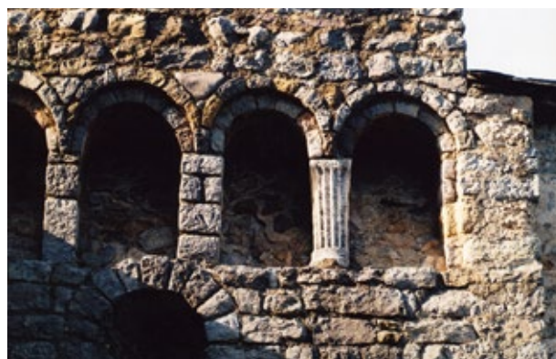
Figura 4. Detalle de la iglesia de Sant Joan de Bellcaire, con material romano reutilizado en la obra cristiana. Fotografía de Jordi Contijoch.
