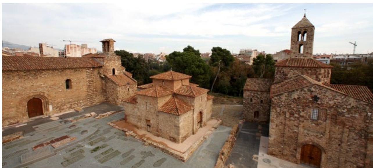
Figura 1. Conjunt Monumental de les esglésies de Sant Pere de Terrassa.
