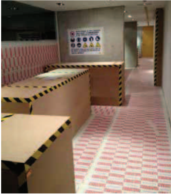
Figura 129. Els mobles protegits just abans de l'inici de les obres. © Electrojar.
