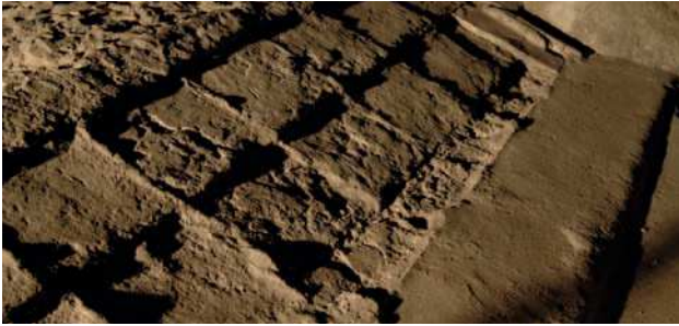
Fig. 18. Traccia delle tegole di copertura al di sopra del cementizio della volta di copertura del medesimo ambiente (Archivio della Sovrintendenza ai BB.CC. del Comune di Roma, Museo dei Fori Imperiali).
