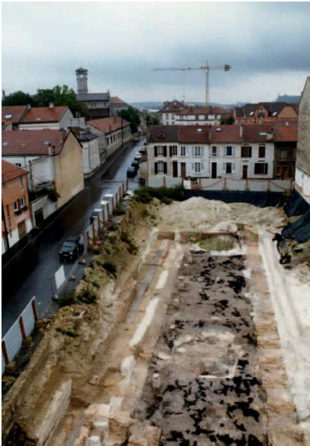
Fig. 8 : Reims, rue Belin. Vue d'ensemble de la salle –avec la toiture brûlée au sol– et de l'égout (à gauche). Photo Ph. Rollet, INRAP.
