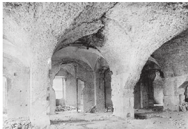
Fig. 13. La Grande Aula prima dei lavori di demolizione delle opere realizzate per il convento di Santa Caterina: sono visibili le volte seicentesche che coprivano i corridoi scoperti al piano superiore (Archivio della Sovrintendenza ai BB.CC. del Comune di Roma, Museo dei Fori Imperiali).
