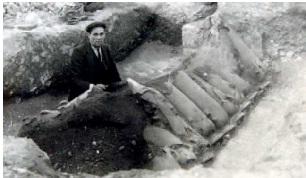
Fig. 6. Detalle de la excavación de una cisterna con cubierta de ánforas tardo-republicanas Mañá C2 A (Serra Vilaró 1932, lám. XX). Esta cisterna quedó cortada por la construcción del gran edificio forense (v. fig. 6).
