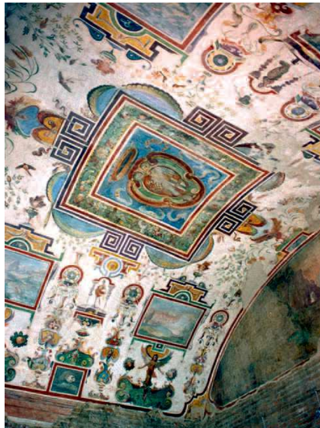
Fig. 17. Affresco cinquecentesco sulla volta di copertura in un ambiente all'ultimo piano del Corpo Centrale (Archivio della Sovraintendenza ai BB.CC. del Comune di Roma, Museo dei Fori Imperiali).
