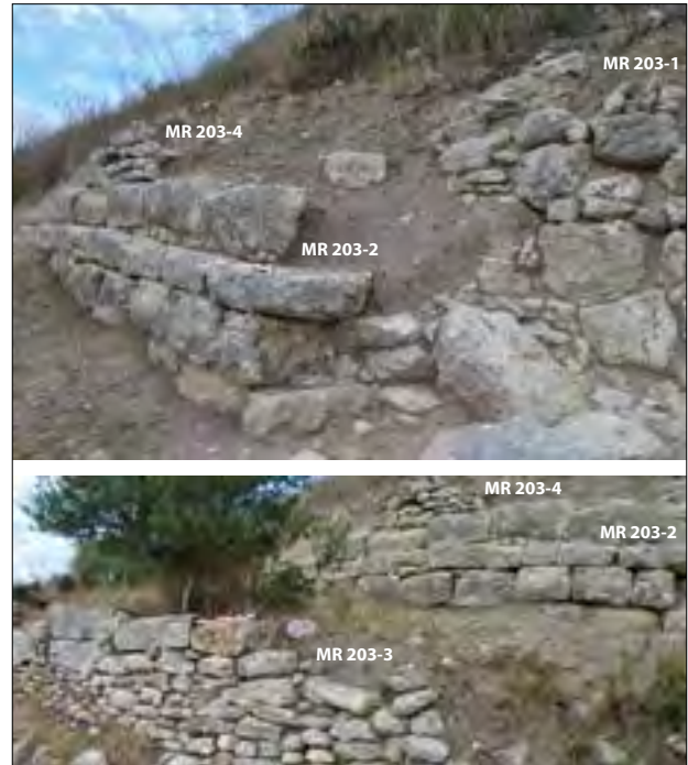
FIGURE 14. Le mur d'enceinte MR-203-2, avec, en arrière, le dispositif de soutènement de la corniche rocheuse (MR 203-1). Les autres structures sont postérieures à la période protohistorique.
