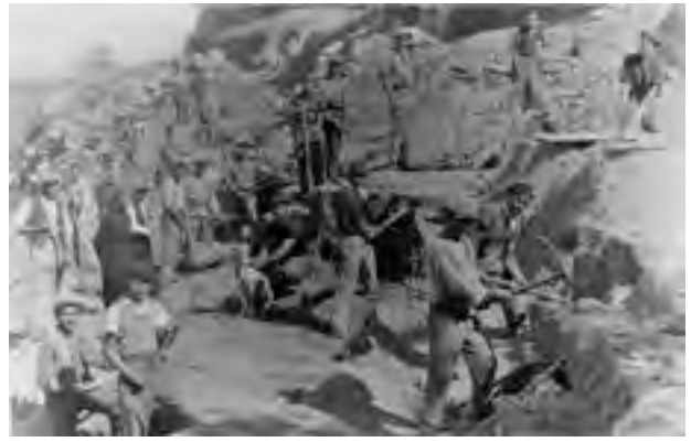
FIGURE 4. Louis Sigal et ses ouvriers terrassiers au cours des fouilles des années 1930.
