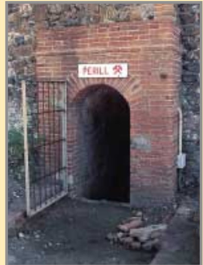
Acceso por escaleras a la planta "Els vells" de mina Eugenia. Esta entrada se conserva en perfectas condiciones y ha sido restaurada para el programa de visitas. Foto: G. García, 1998.
