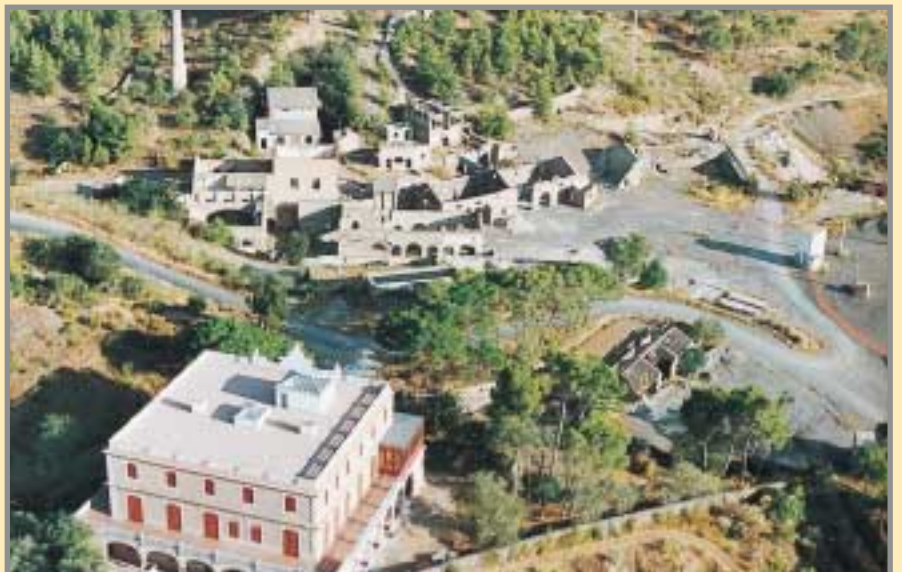
La dilatada historia de las minas de Bellmunt: Imagen aérea actual de las instalaciones de mina Eugenia.
