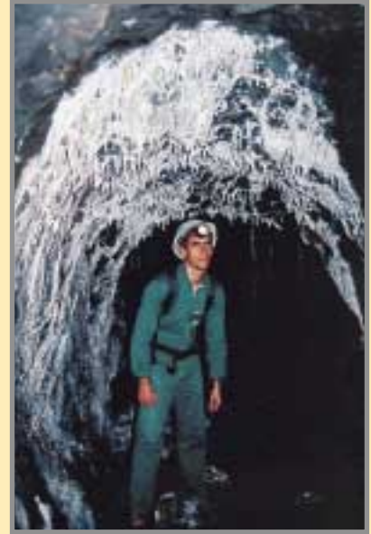
Carbonato calcico depositado por filtraciones en la 1ª planta de la mina Eugenia. Año 1998. Foto: G. García.
