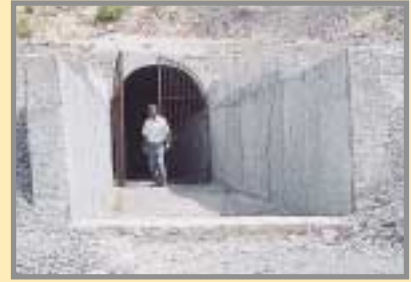
Aspecto de la salida de emergencia de mina Eugenia, una vez finalizadas las obras en el año 2000. Foto: Fernando Gómez.
