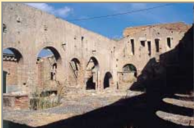
Restos del lavadero de la mina Eugenia. Foto: G. García, 1998.
