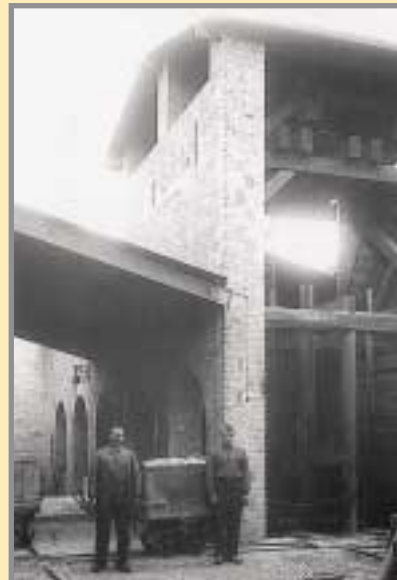
Mineros frente a la boca del pozo San Jacinto de la mina Eugenia en el año 1904. Foto: Museo - Archivo Municipal de Calella.
