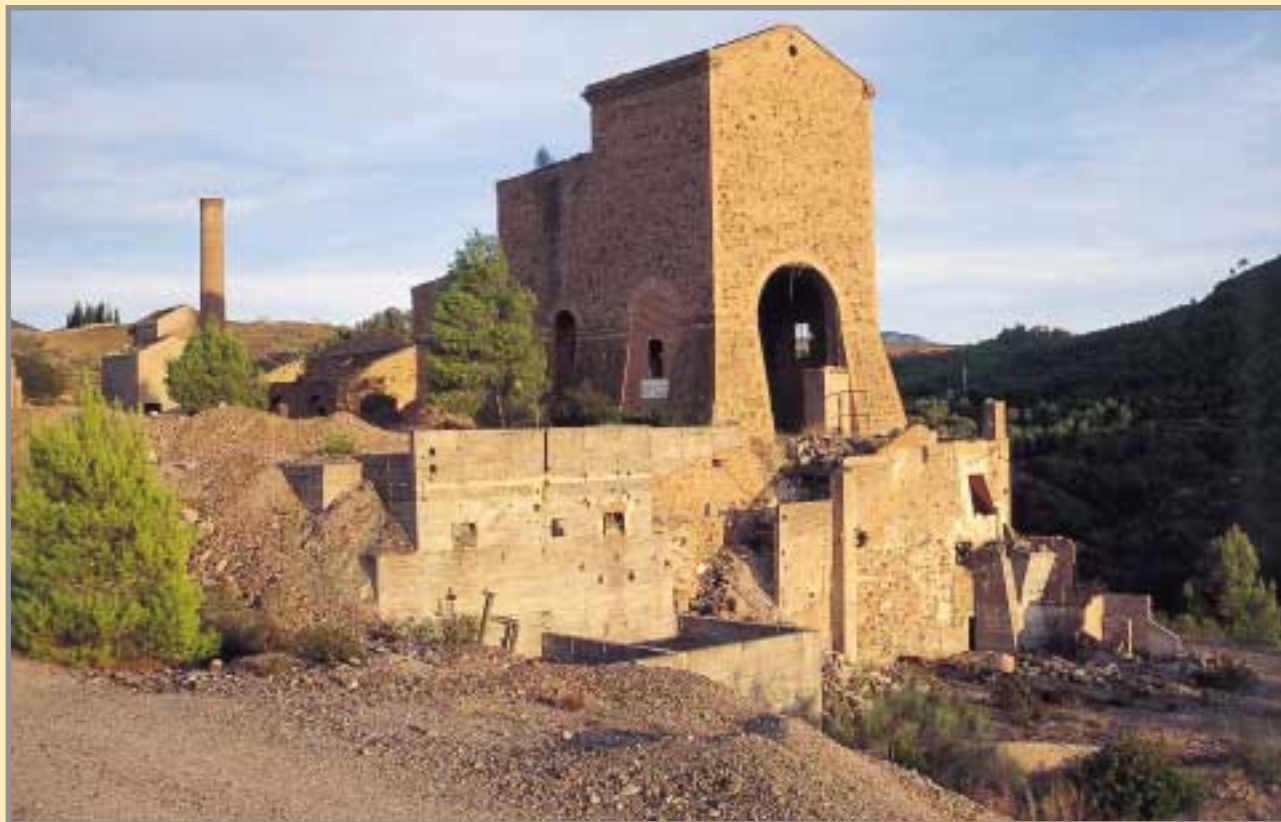
Vista general del estado en 1998 de las instalaciones de la mina Regia. Destaca el bello castillete de mampostería. Foto: G. García.
