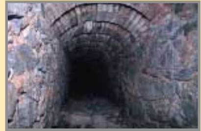
Socavón de mina Ramona. Foto: J. Abella.
