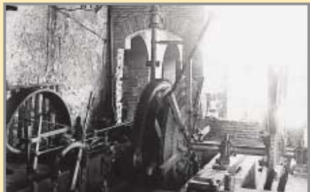
Maquinaria de extracción a vapor que accionaba las gavias del pozo San Jacinto (1906). Foto: Museo - Archivo Municipal de Calella.
