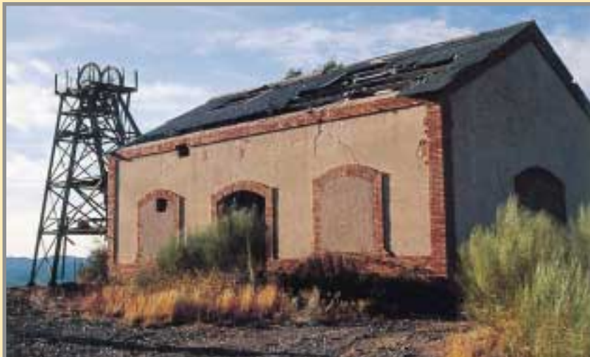
Mina Renania, castillete y casa de máquinas antes de su traslado a la plaza de la mina Eugenia. Esta mina tuvo sus trabajos en 1928. Foto: G. García, 1998.
