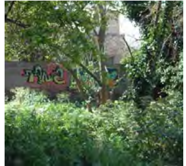
>Murs de contenció edificats sobre l'espada dels antics fronts d'explotació (foto A. Alvarez).
