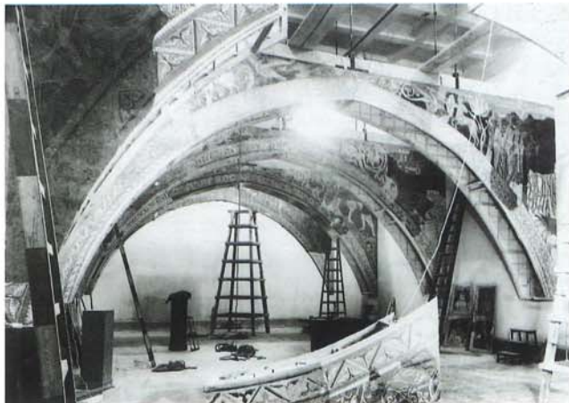
Palau Nacional, treballs d'instal·lació de les pintures de la sala capitular de Santa Maria de Sixena, el 1961.
