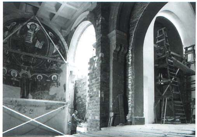
Palau Nacional, obres d'habilitació de la nova instal·lació de l'absis de Sant Climent de Taüll, 1972-1973.
