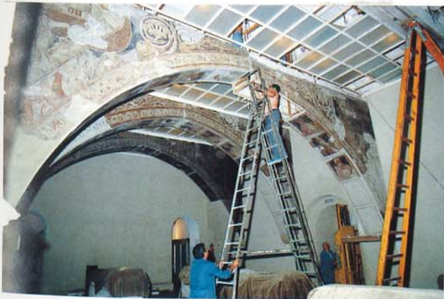
Desmuntatge de les arcades de la sala capitular de Sixena, a l'antigua sala 26 de la instal·lació de 1973 (setembre de 1987).
