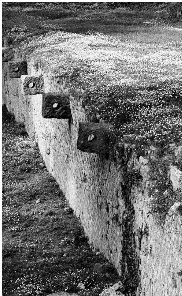
Figura 15. El muro con los bloques perforados de Pompeya.
