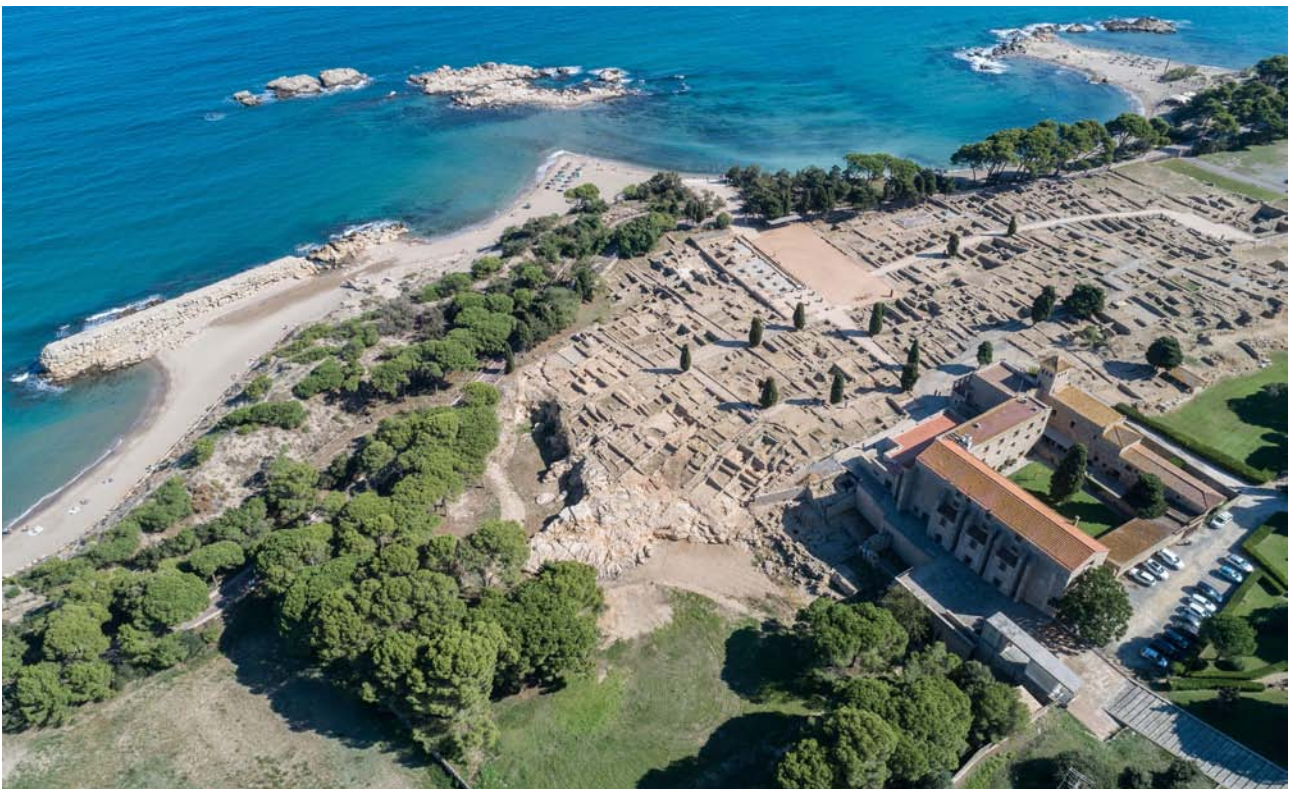
Figura 6. Vista aèria del sector nord de la ciutat grega d'Empòrion. Els treballs d'excavació realitzats els darrers anys han permès recuperar la paleotopografia i visualitzar la relació del nucli grec amb l'antic port.
