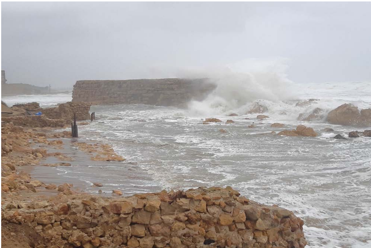
Figura 10. La única infraestructura conservada del “port artificial” és l’anomenat “espigó d’Empúries”, un gran mur fet de pedres i opus caementicium que definia per l'oest la bocana. Imatge presa durant el temporal “Glòria” el dia 21 de gener de 2020, que posa de manifest la seva funció de pantalla protectora del sector nord-est de la ciutat grega.
