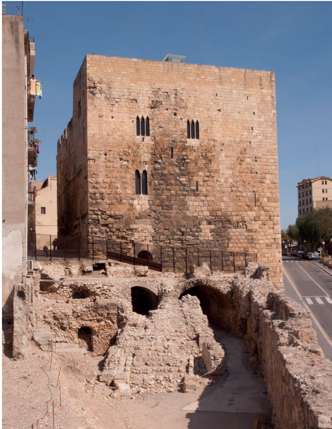
Figura 13. Façana de la Torre del Pretori amb les restes de l'escalinata d'accés. Fachada de la Torre del Pretori con los restos de la escalinata de acceso.
