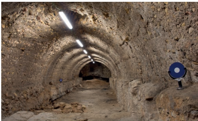
Figura 38. Volta conservada sota el carrer dels Ferrers. Anterior al Circ. Bóveda, conservada debaixo de la calle del Ferrers.
