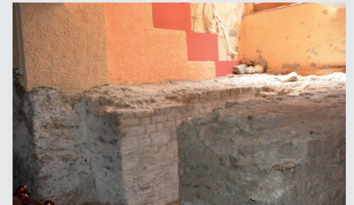
Figura 45. Detall parament opus vittatum en una de les portes d'accés (c/ Trinquet Vell). Detalle del paramento de opus vittatum en una de las puertas de acceso (c/ Trinquet Vell).
