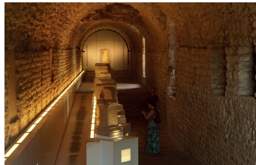
Figura 17. Volta de fonamentació de la Torre del Pretori. Bóveda de cimentación de la Torre del Pretori.
