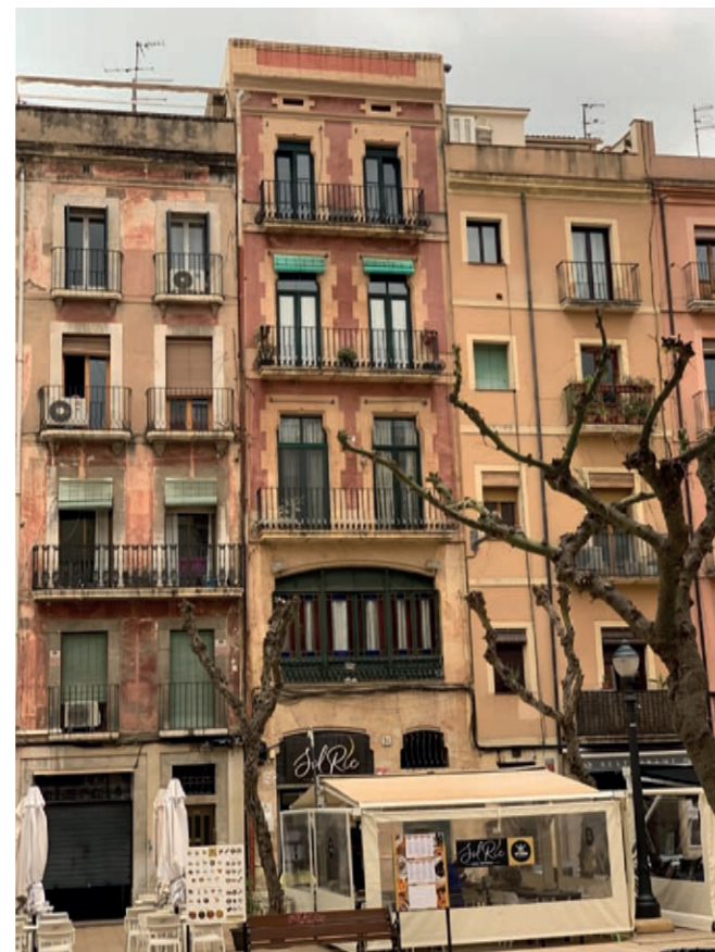
Figura 30. Façana de la plaça de la Font 27. Costat Sud de la plaça. Fachada de la plaça de la Font 27. Lado sur de la plaza.
