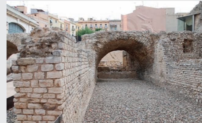
Figura 44. Detall parament opus vittatum en una volta de sustentació. Detalle del paramento de opus vittatum de una bóveda de sustentación.
