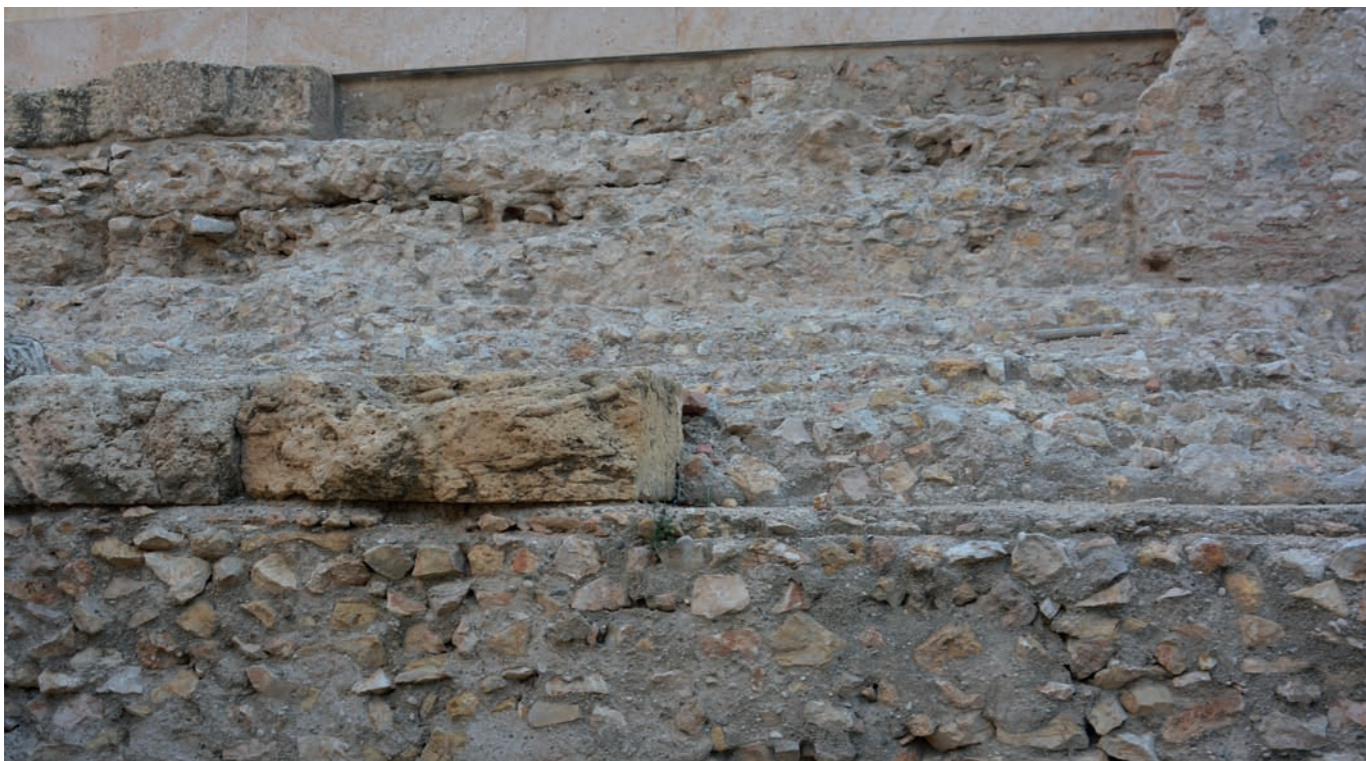
Figura 55. Detall del llit de morter previ a la col·locació dels seients. Detalle del lecho de mortero previo a la colocación de los asientos de piedra.
