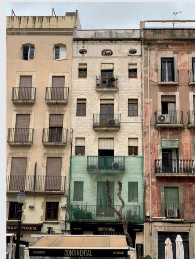
Figura 31. Façana de la plaça de la Font 31. Costat Sud de la plaça. Fachada de la plaça de la Font 31. Lado sur de la plaza.
