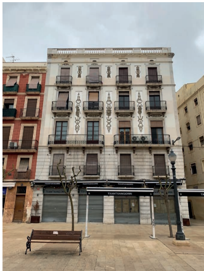
Figura 29. Façana de la plaça de la Font 16. Costat Nord de la plaça. Fachada de la plaça de la Font 16. Lado norte de la plaza.
