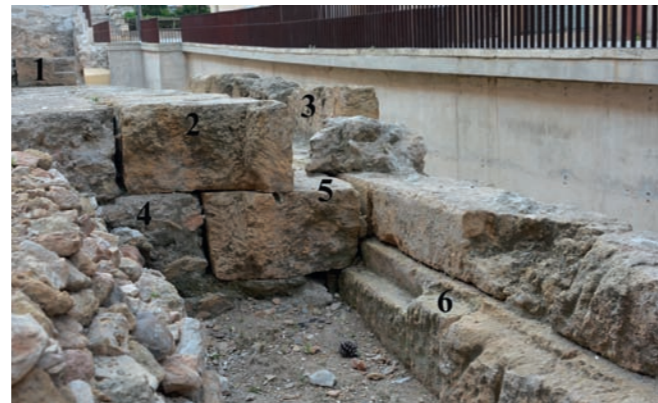
Figura 43. Detall de la ima cavea . 1) escala de comunicació; 2) seient inferior; 3) balteus ; 4) base de caementicium de la summa cauea ; 5) nivell de la praecintio ; 6) àrea contacte amb el podi amb el carreu retallat per adaptar-se a aquest. Detalle de la ima cavea : 1) Escalera de comunicació; 2) Asiento inferior; 3) Balteus ; 4) Base de caementicium de la summa cauea ; 5) Nivel de la praecintio ; 6) Área de contacto con el podio con un sillar recortado exprofeso.
