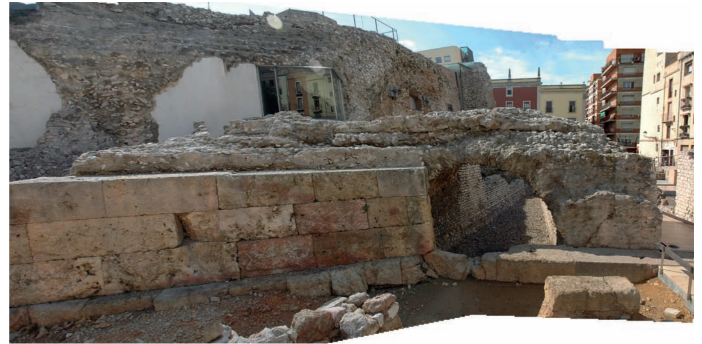
Figura 47. Mur de carreus del podi folrant el nucli de caementicium . Muro de sillares del podio forrando el núcleo de caementicium .
