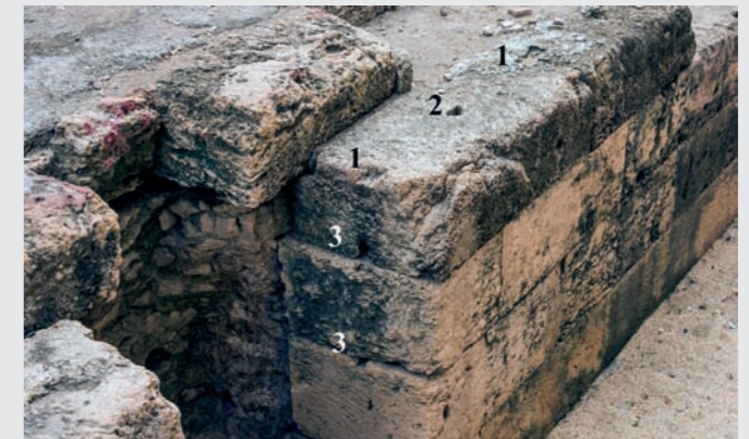
Figura 41. Detall dels carreus del podi. 1) encaixos grapa cua d'oreneta; 2) encaix per elevació; 3) encaixos per desplaçament lateral dels carreus. Detalle de los sillares del podio: 1) Encajes de grapa de cola de milano; 2) Encaje para elevación; 3) Encaje para el desplazamiento lateral de los bloques.
