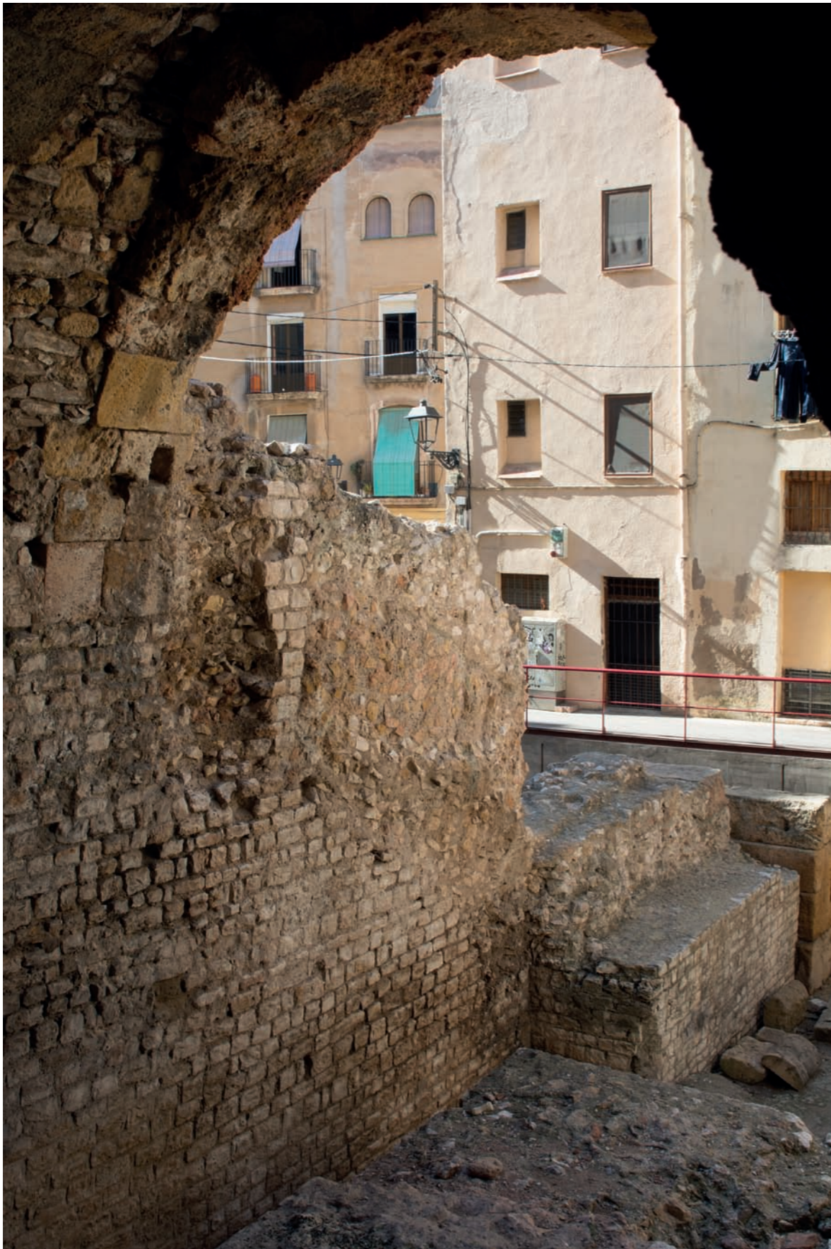
Figura 46. Volta de la graderia nord i cobertura d'una de les caixes d'escales (pl. Sedassos). Bóveda de la gradería norte y cobertura de una de las cajas de escalera (pl. Sedassos).
