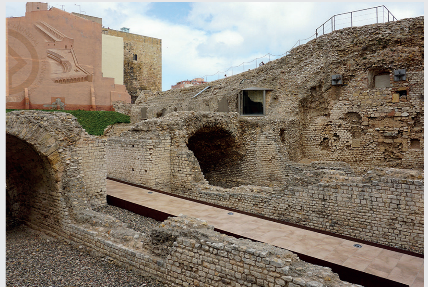
Figura 12. Voltes de sustentació de la graderia meridional. Bóvedas de sustentación de la gradería meridional.
