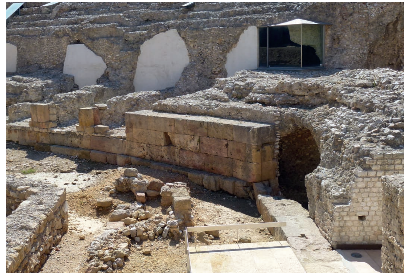
Figura 10. Detall del podi de carreus del Circ amb les estances medievals obertes en la part inferior de la ima cauea . Detalle del podio de sillares del Circo con los espacios medievales abiertos en la parte inferior de la ima cavea .
