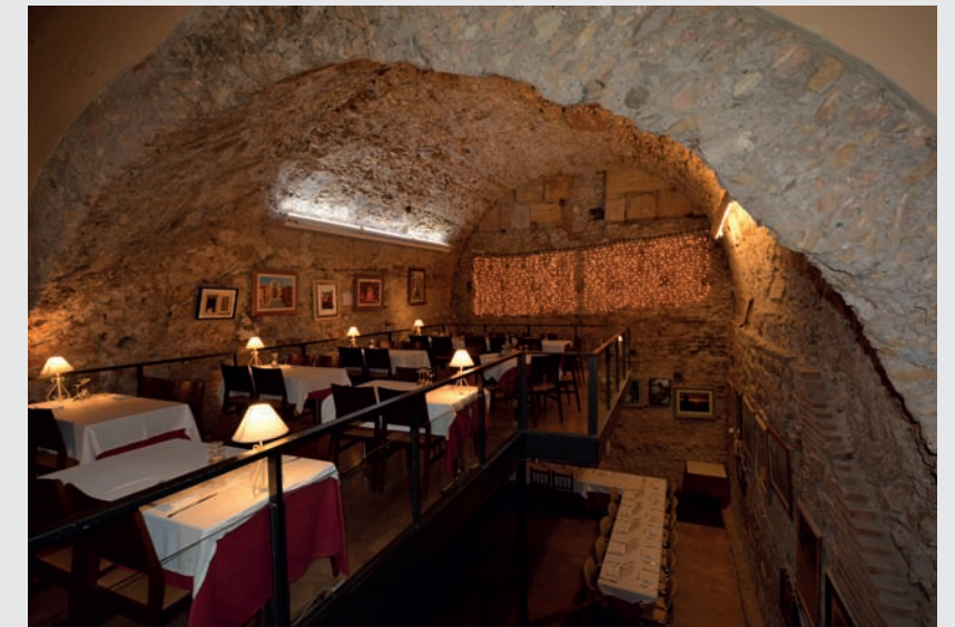
Figura 21. Volta sustentació de la gradería nord. Restaurant Les Voltes. Bóveda de sustentació de la gradería norte. Restaurante Les Voltes.
