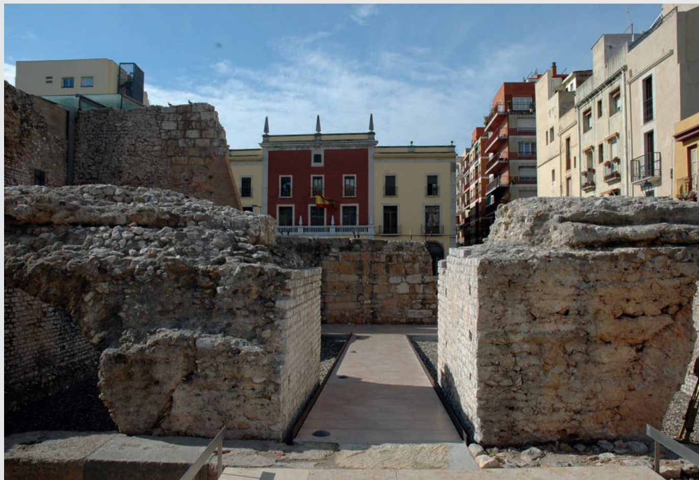
Figura 11. Detall d'una porta de connexió entre l'arena i la façana. Detalle de una de las puertas de conexión entre la arena y la fachada.
