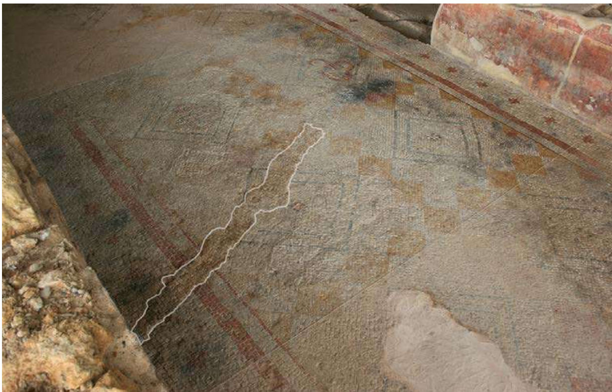
Figura 2.172. Detall del mosaic on s'observa la reparació relacionada amb la col·locació d'una canonada de plom (Arxiu MNAT).
