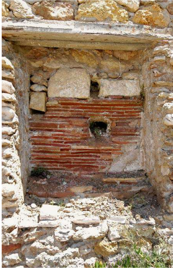
Figura 2.147. Detall de la font de l'àmbit 7.1 (Arxiu MNAT).
