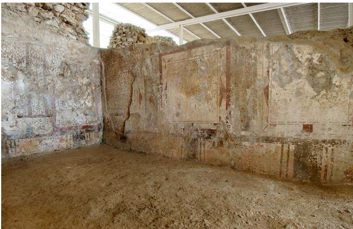
Figura 2.60. Vista des del sud de l'àmbit 2.5 (Arxiu MNAT).
