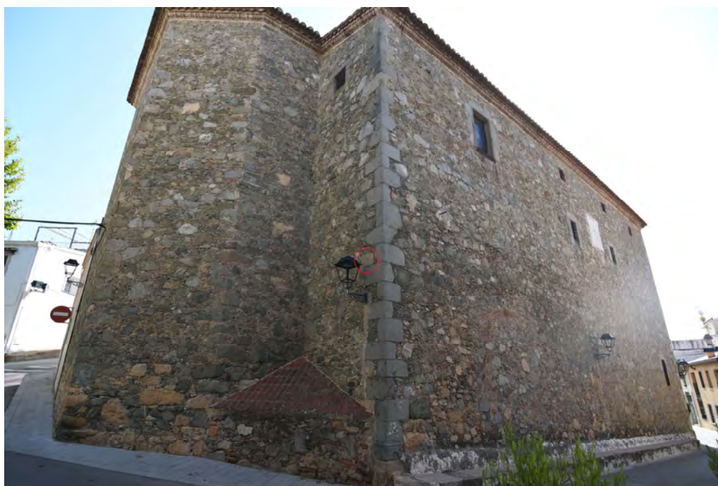
Façana de tramuntana amb el carreu inserit just per sobre del fanal collat a la paret.
