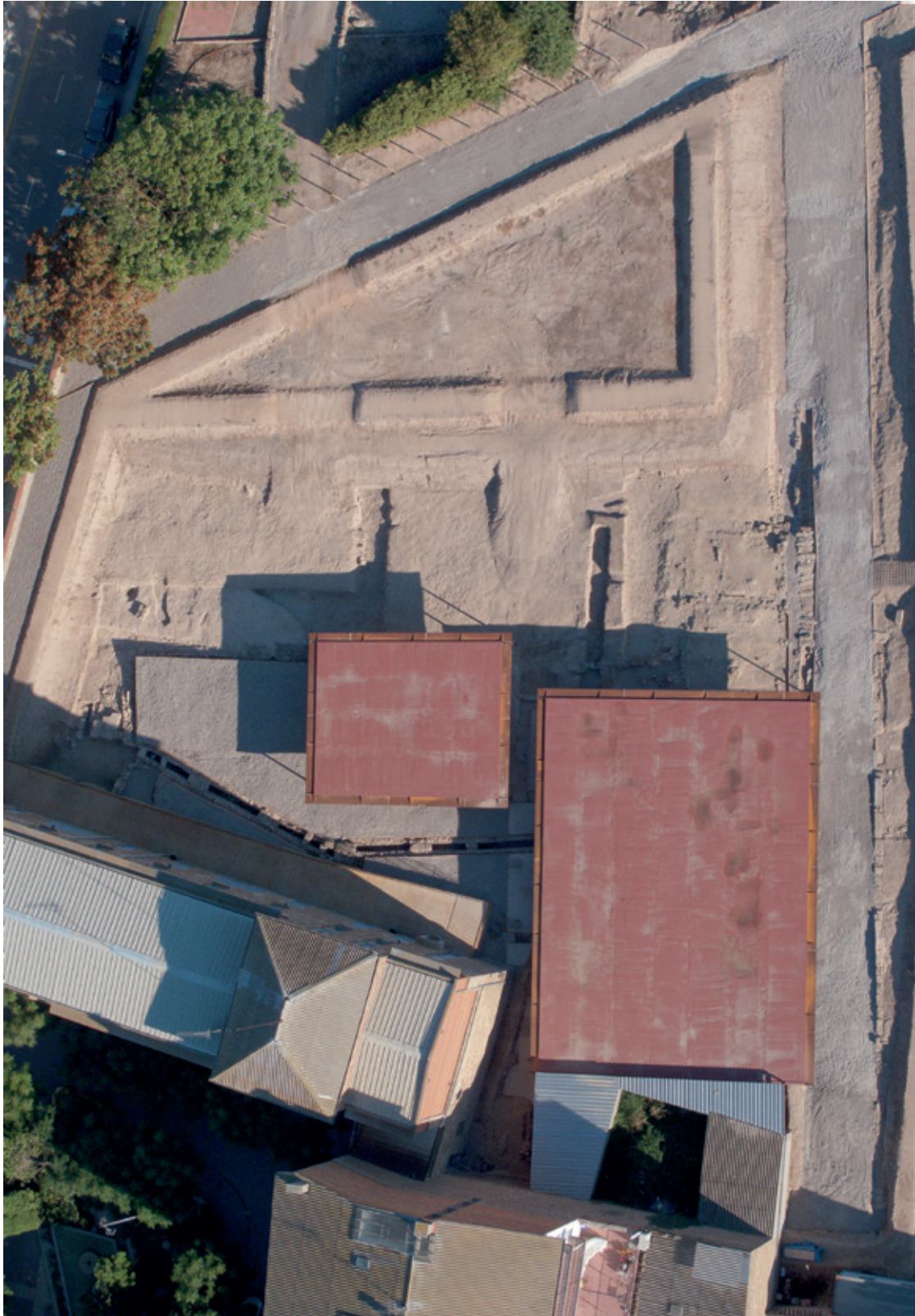
FIGURA 42. Detall de la Insula de les termes vista des del sud. Notem com al davant de la coberta de les restes de l'edifici termal i tocant al cardo hi afloren ja restes de la segona fase de les termes encara pendents d'excavació.
