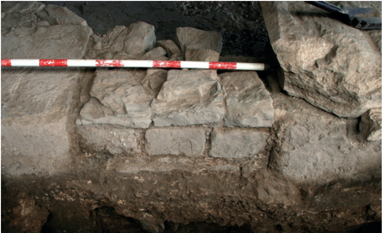
FIGURA 14. Detall de la part alta del tapiat de la porta que a la primera fase havia comunicat la sala rodona del frigidari amb el tepidari. Notem l'inici de la volta de mig punt dovellada d'aquella porta.
