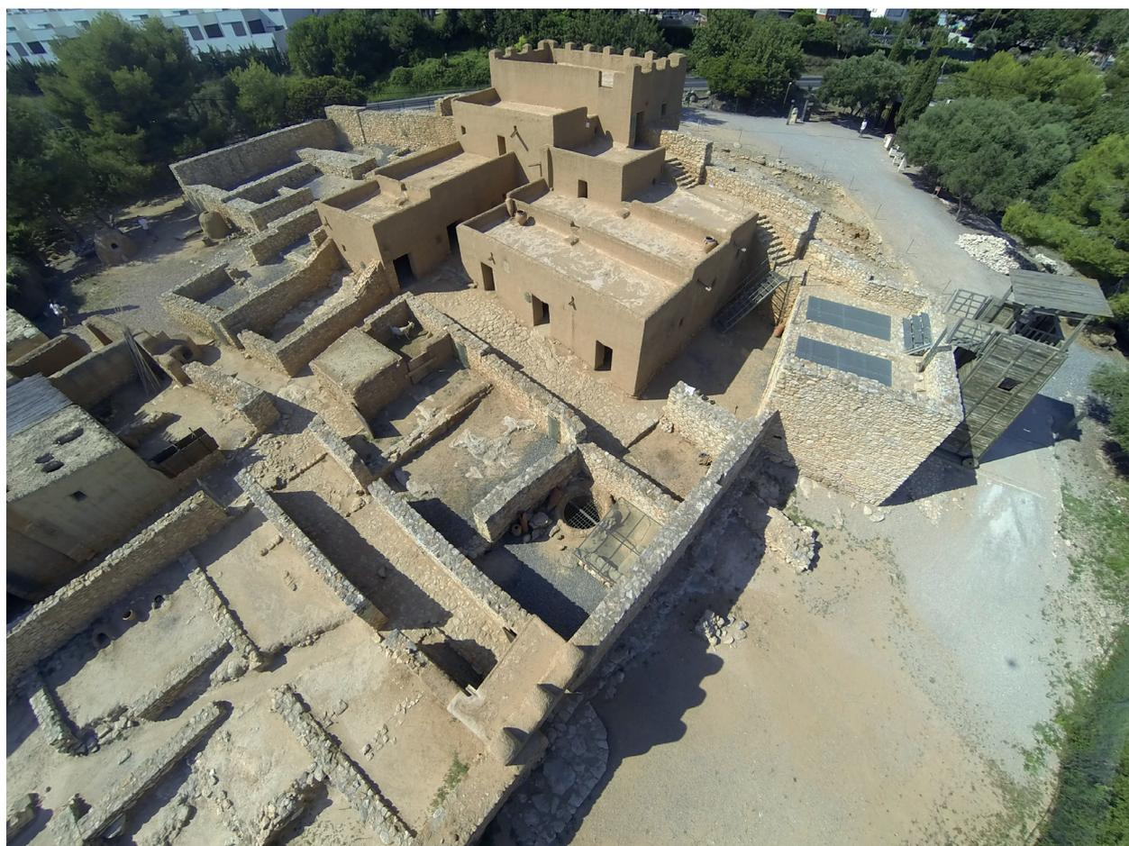
**Fig. 5 : Vue aérienne du site d'Alorda Park, à Calafell. A noter la partie reconstruite, avec des élévations enduites en terre et des toitures en terre à faible pente ou plates (Bonavista Multimedia).**
