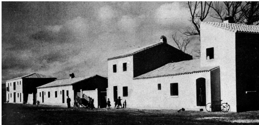
118 Viviendas de colonos de Sobradriel.
